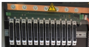
Figura 4 Conexionado en la PCB
